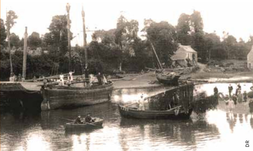
Le chantier naval Hily au Pouldu. On aperçoit l'atelier au second plan, au centre et un pan du moulin à droite, au bord de la photo
